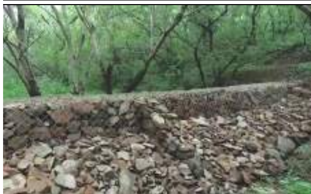
चित्र: वन और वन्यजीव विभाग, रा.रा.क्षे. दिल्ली सरकार द्वारा असोला भाटी में चेकडैम का निर्माण
